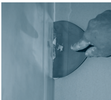
5. Stuccare dopo l'applicazione delle lastre
