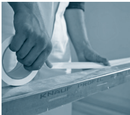
1. Applicazione del nastro autoadesivo Knauf Trennfix sul profilo a "C" o ad "U"
