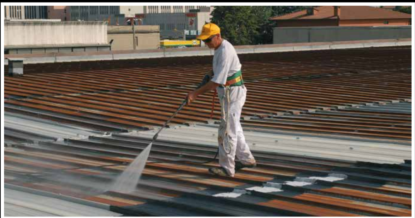
Prima fase di pulizia con idropulitrice ad alta pressione per eliminare ruggine, sporco ecc. ecc.
