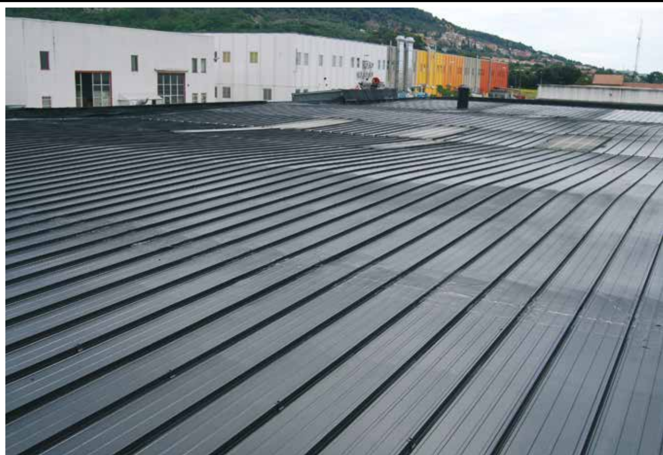
Aspetto della copertura metallica dopo il trattamento realizzato con due mani di ElastiK stese a distanza di 48 ore una dall'altra (applicazione a spruzzo con un consumo totale di 1 kg/m 2 )
