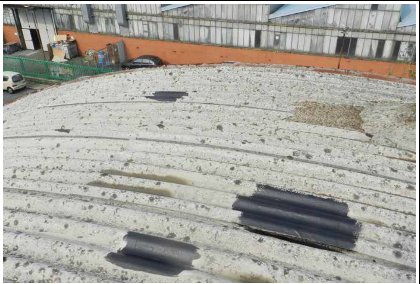
Evidente risultato della rottura della copertura in fibro-cemento per effetto delle grandine
